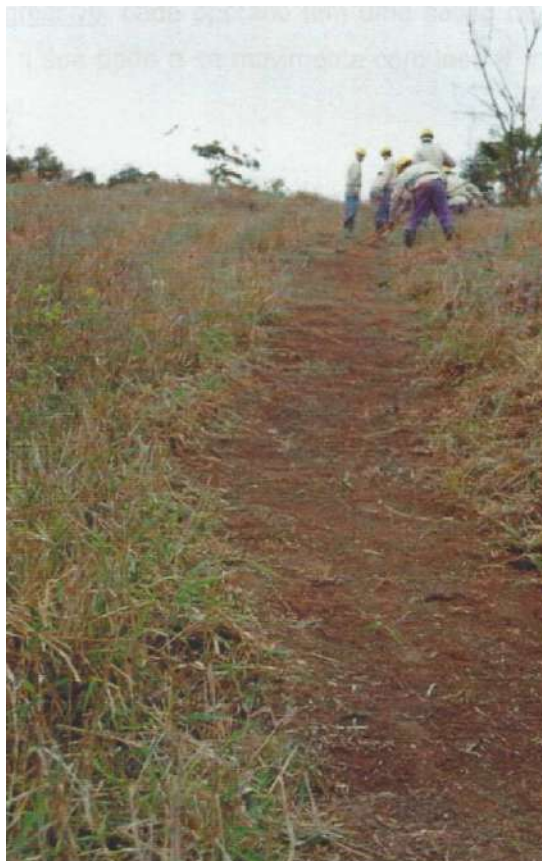
Figura 41 - Linha de defesa construída manualmente.
